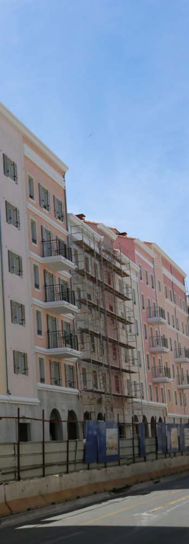
Rénovation de l'entrée du Pont-du-Las
